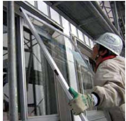
窓の断熱改修（外付サッシの附加）
