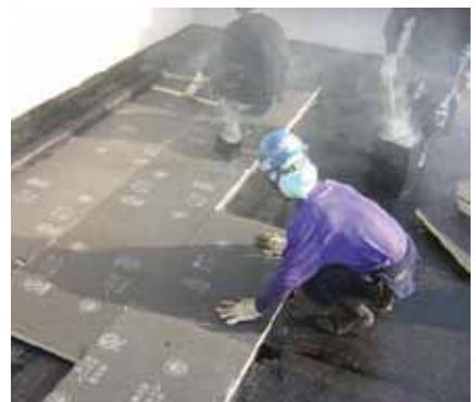
屋根スラブの外断熱改修（断熱保護防水）
