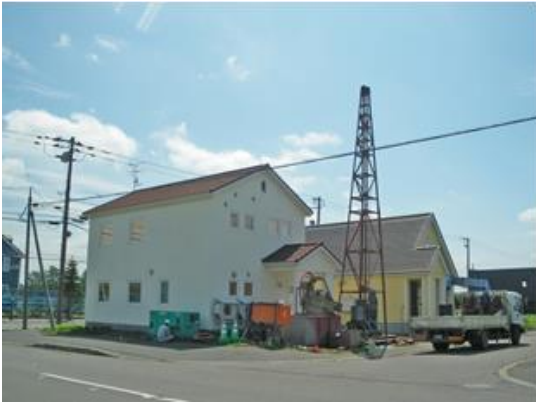
写真 3 ボアホール式地中熱ヒートポンプの施工
