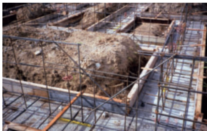
図資 1-3-1 基礎の配筋
