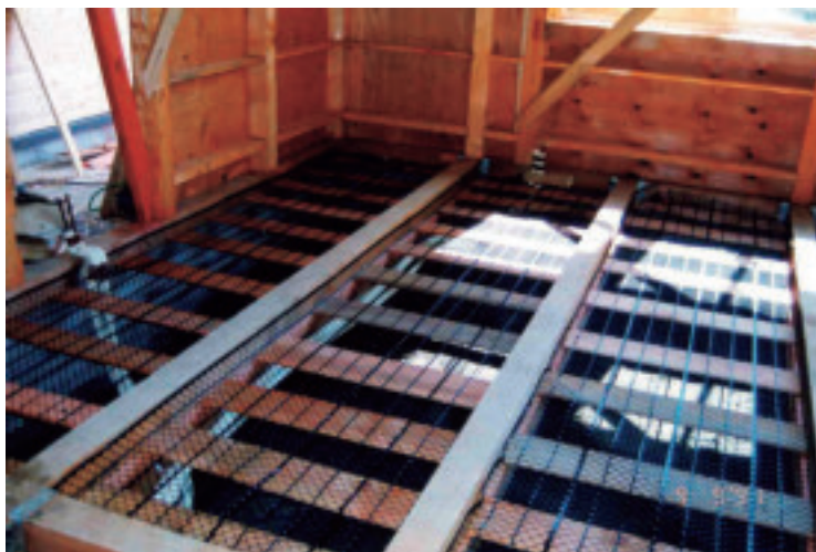
図資 7-5-4 床の断熱受材の施工例
