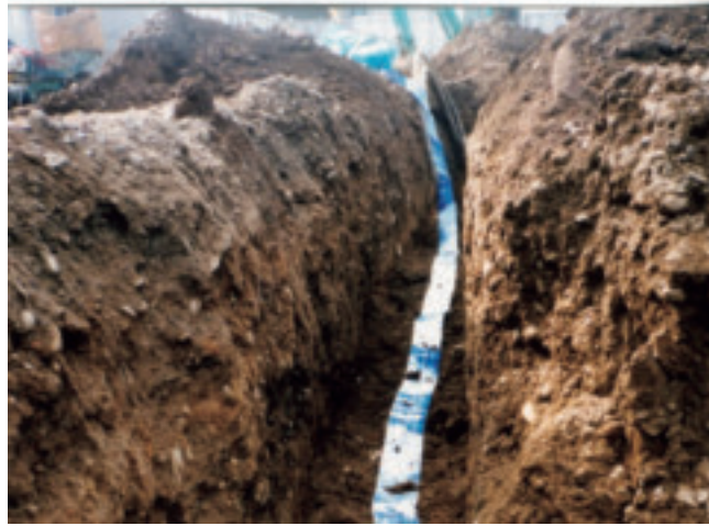
図3-1-2 地中埋設管の表示テープの施工例
