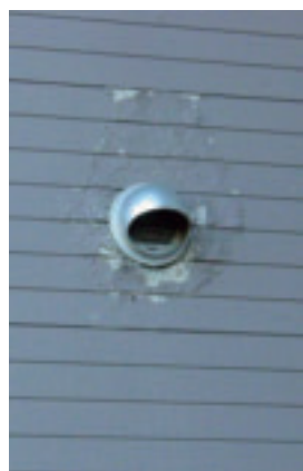
図 1-6-3 水切りがない換気部材による冬季障害
