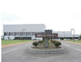
南幌町スポーツセンター
