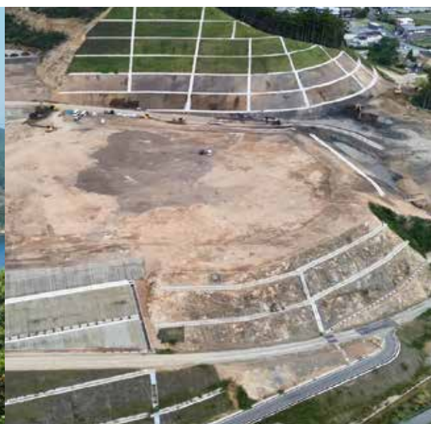
高台造成地(整備中)
