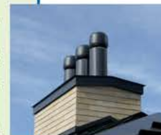
⑧パッシブ排気筒：鳩小屋方式(左)と断熱排気筒方式(右)
