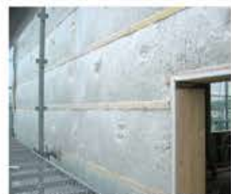
壁の断熱材(壁の厚さ200mm)
