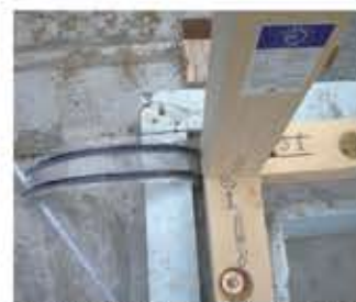
基礎断熱及び基礎と土台の気密
