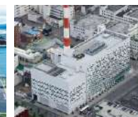
札幌発電所 (北ガスグループ本社)
