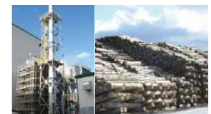
苫小牧バイオマス発電 (道内産の未利用木材を使用)
