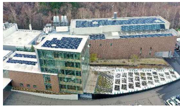
▶ 太陽光パネル
