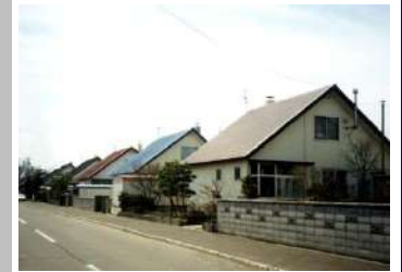
ブロック三角屋根住宅の街並み
