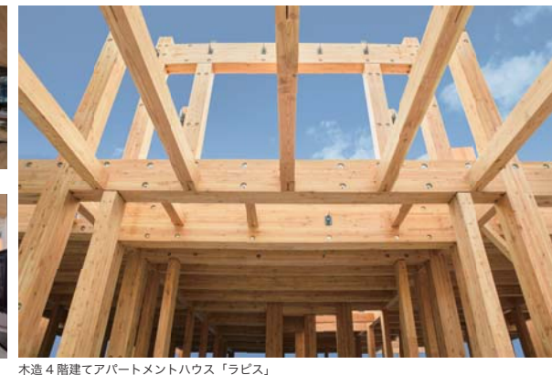
木造4階建てアパートメントハウス「ラピス」
