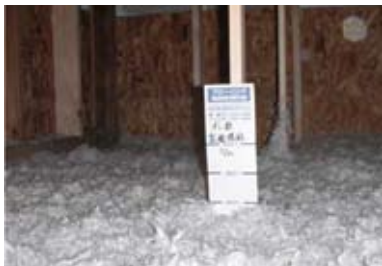
天井裏の断熱工事
