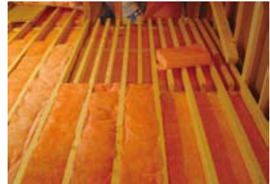
床の断熱工事
