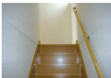
手すりの設置（階段）
