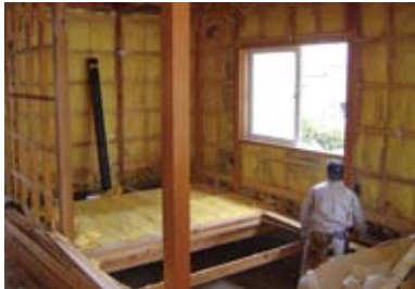
既存部分の解体（古い断熱材の様子）
