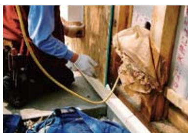
構造用合板による補強
