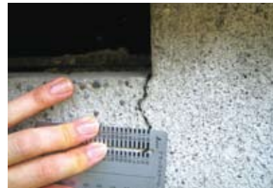
外壁等のひび割れの確認(クラックスケールによるひび割れ幅の測定)
