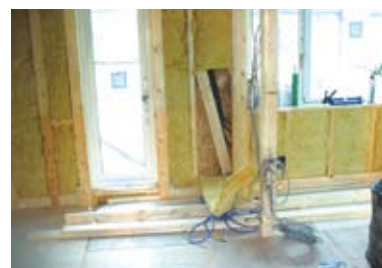
耐力壁の追加（大きな開口部の一部を耐力壁に改造）
