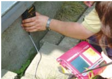
基礎鉄筋の有無の確認(鉄筋探査機)
