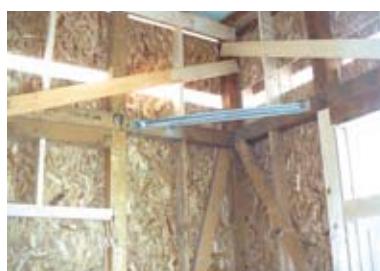
耐震金物による補強
