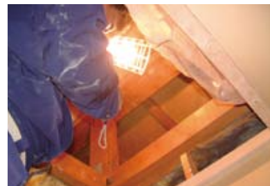
小屋裏の確認
