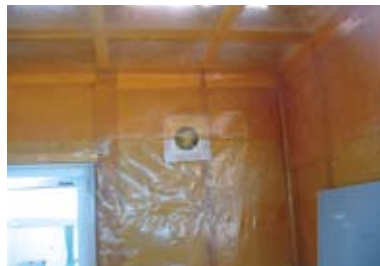
防湿気密フィルムによる気密工事と壁貫通部の気密テープによる処理
