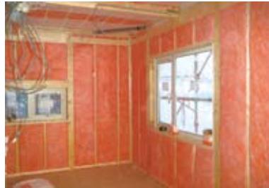
あらためて断熱材を施工
