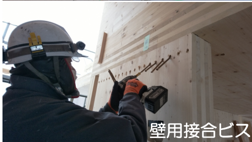
壁パネル施工
