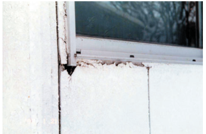
凍害によりひび割れたサイディング。漏水の原因となります。
