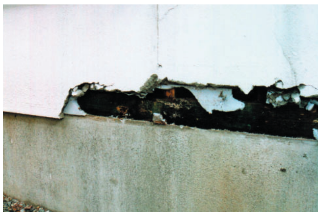
土台の腐食。夏場の換気により回避できます。
