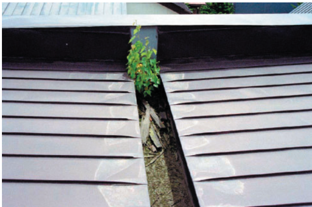
ドレーンパイプの詰まり。住宅内部への漏水のおそれがあります。
