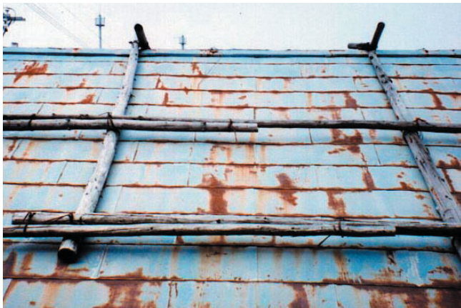
塗装が剥がれ錆びた屋根。このままでは腐食の原因になります。
