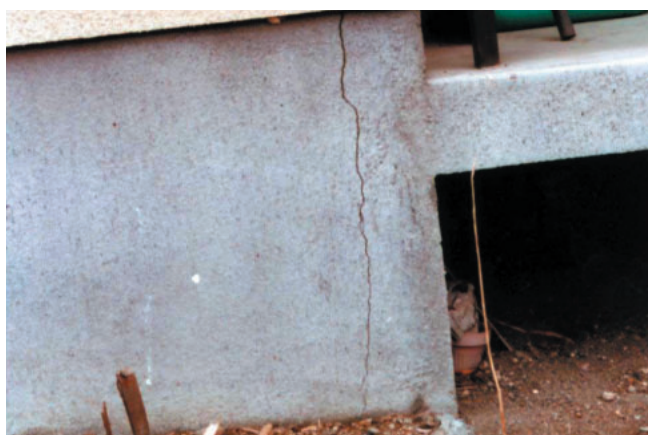
ひび割れた基礎。
