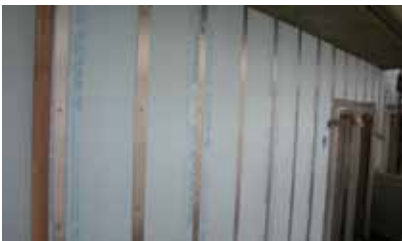
鋼製下地材 (プラスチック断熱材)
