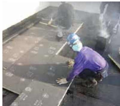
屋根スラブの外断熱改修例(断熱保護防水)
