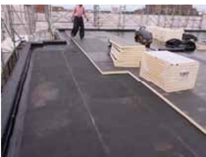
屋上部断熱施工
