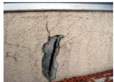
コンクリートの爆裂
