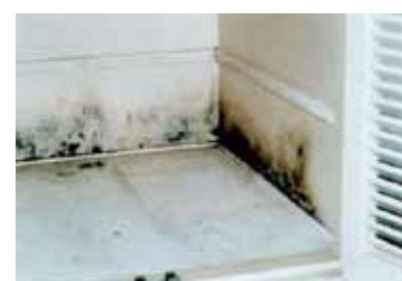
内断熱マンションの結露例(クローゼット)
