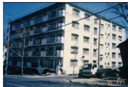
1階の駐車場が崩壊したマンション (1995年阪神・淡路大震災)
