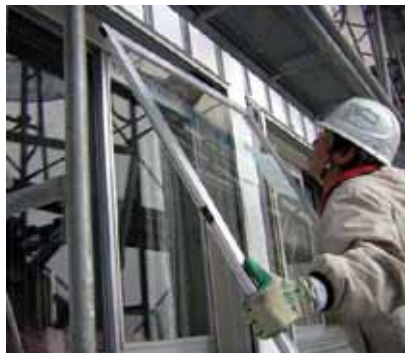
窓の断熱改修例(外付サッシの追加)
