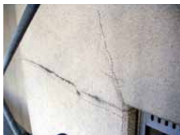
窓廻りのひび割れ
