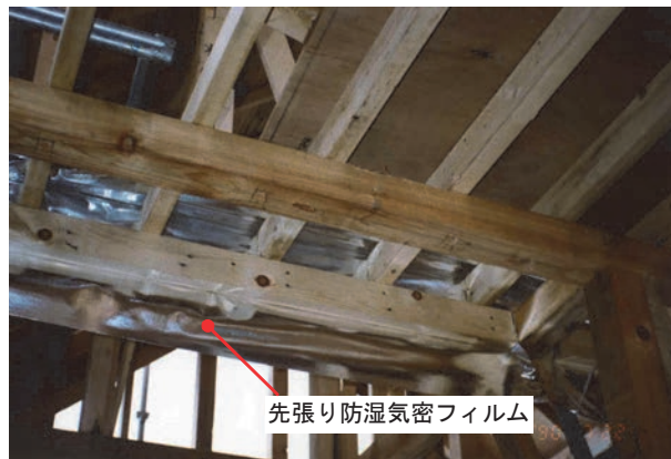
図 6-19 下屋部分の先張り防湿気密フィルムの施工例
