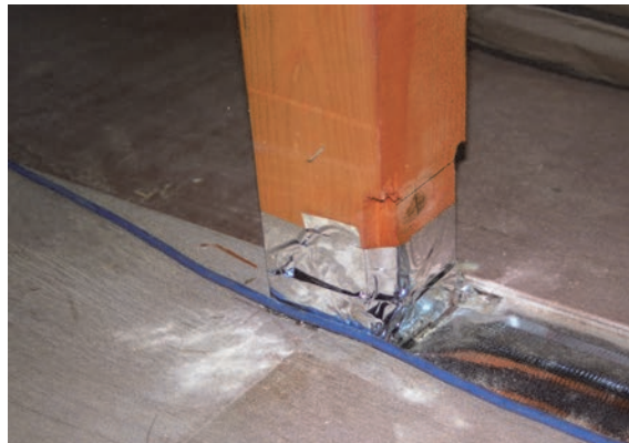
図 6-24 柱下部が防湿気密フィルムを貫通する部分の施工例
