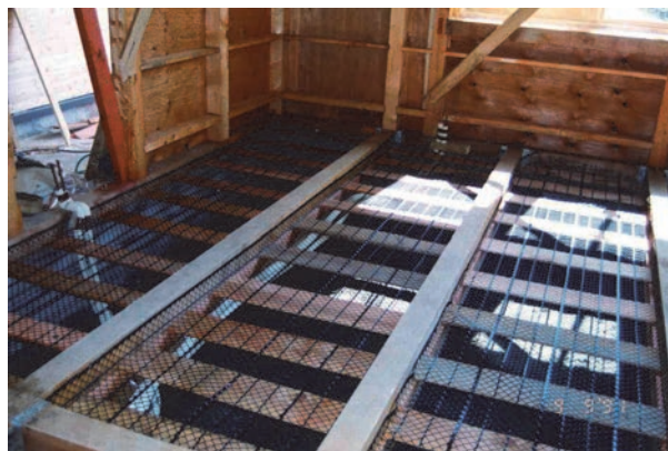
図 6-6 床の断熱受材の施工例
