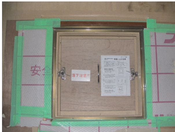
図 6-20 気密住宅専用の床下点検口による断熱気密化
