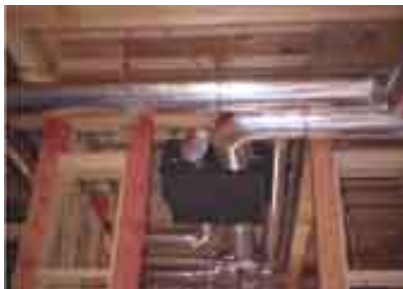
天井裏に設置される換気装置。家全体の換気量をコントロールできます。
