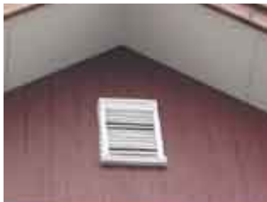
小屋裏の換気口
